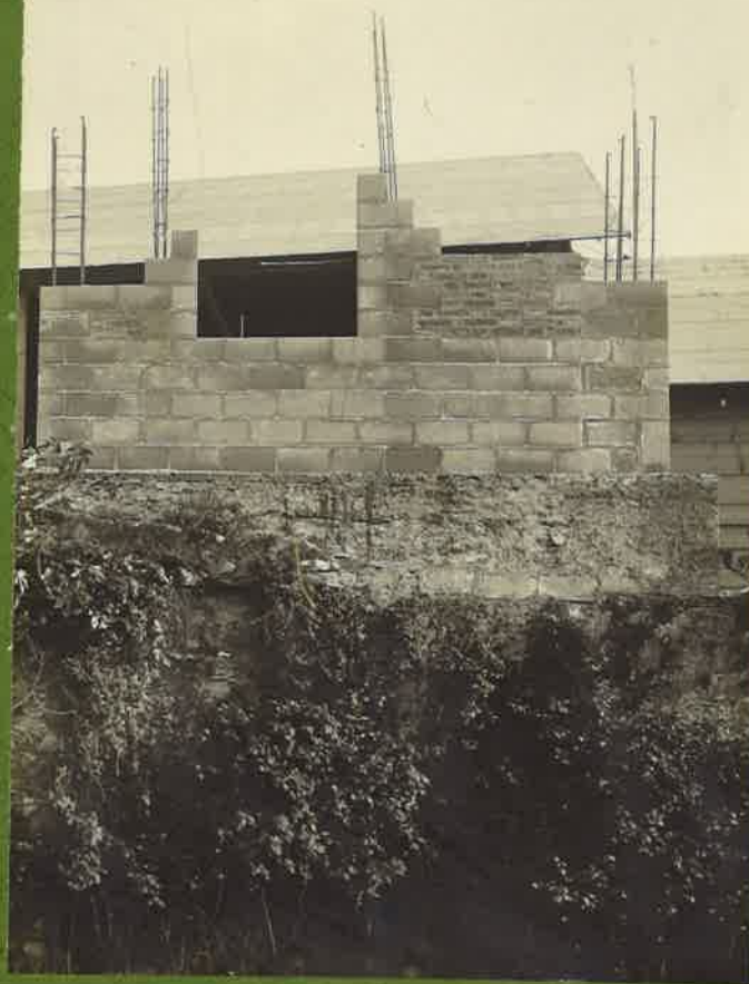
Fig.29- Costruzione mista in blocchi e in laterizi
